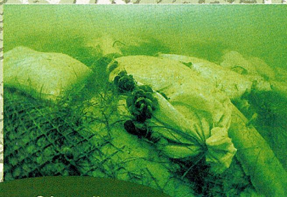
Géotextile et sacs de sable.
